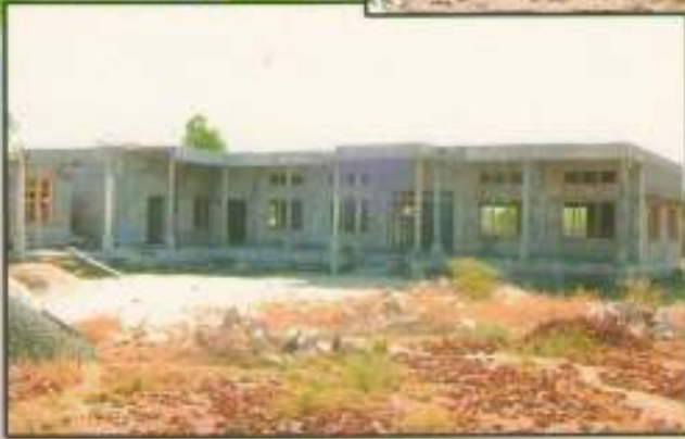
निर्माणाधीन भोजनशाला (मेन गेट, रसोई घर, भोजनकक्ष, स्टोर रूम, भंडार गृह) कुल ५२०० वर्गफुट
